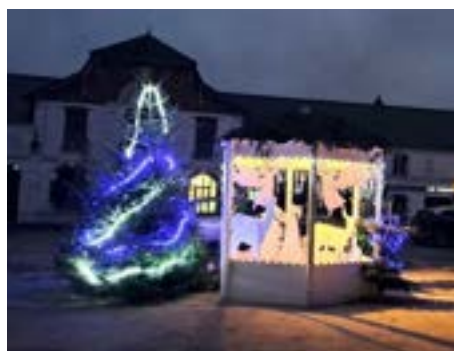
Installation des illuminations sur la place
