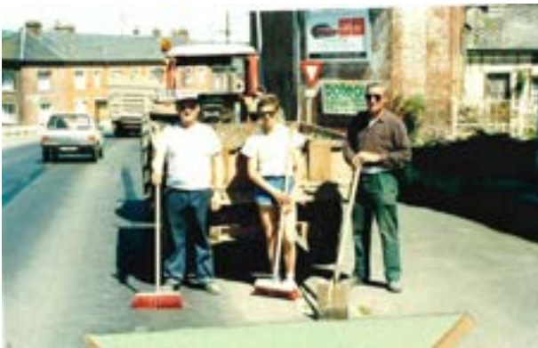
Travaux de voirie – 1990
