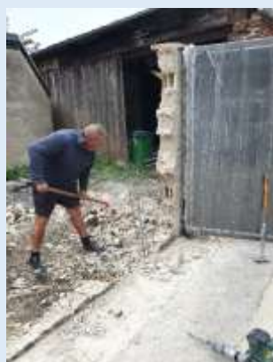
Démolition du mur de séparation du garage
