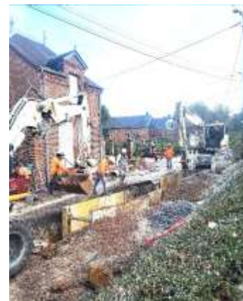
Rue du Point du Jour
