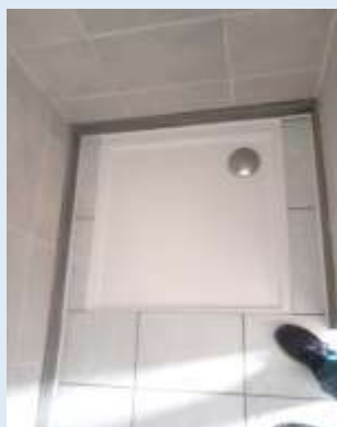
Remplacement d'un bac à douche – Hôtel Entre Nous
