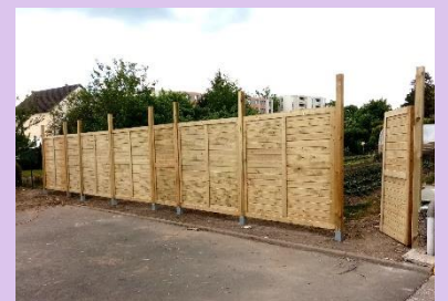
Installation d'un abri pour containers et pose d'une palissade en bois
