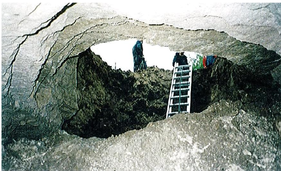
Cavités souterraines à Crouy-sur-Ourcq
