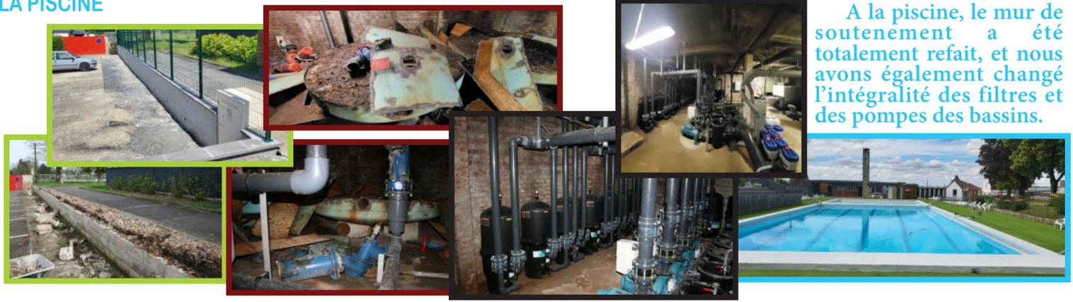
A la piscine, le mur de soutènement a été totalement refait, et nous avons également changé l'intégralité des filtres et des pompes des bassins.
