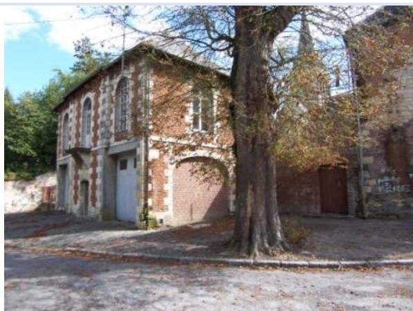
vue de la place de la Motte Avant aménagement
