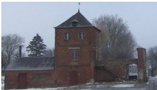
e. Tourelle et entrée porte cochère et porte piétonne
