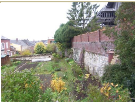
Remparts vus depuis la rue du Signier : Importance des remparts et des jardins devant les remparts à l'extérieur de la vieille ville Avant aménagement
